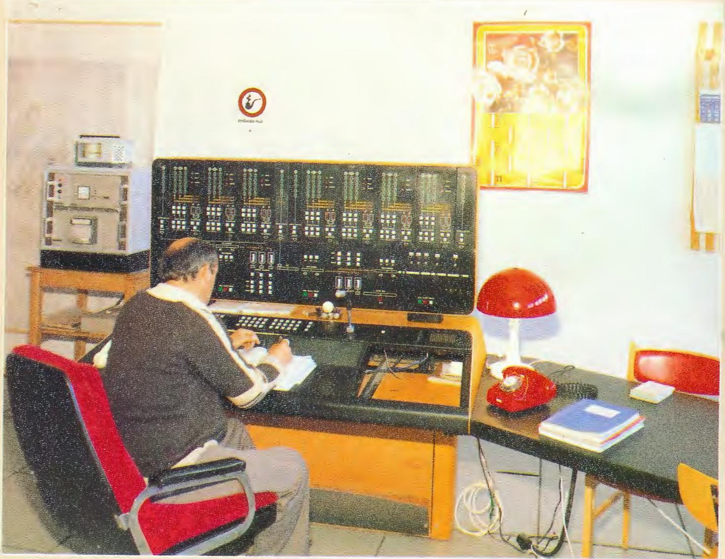
Az intézetben kifejlesztett UTM jelátviteli rendszert építette be a Veszprémi Szénbányák a Márkushegyi bányaüzem díszpécser berendezésébe.
